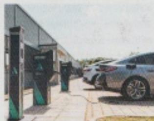
Die Ladesäule »connect.public« von **Heidelberg** bietet zwei Ladepunkte mit einer Leistung von bis zu 22 kW pro Ladepunkt. Die Ladesäule ist barrierefrei gemäß DIN 18040-3. Die Nutzung erfolgt über RFID-Karte, QR-
